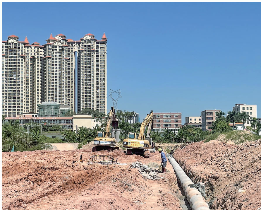
昨日,在市区东粤路南段施工现场,施工人员正在加紧铺设雨污管网,争取项目早日完工。
