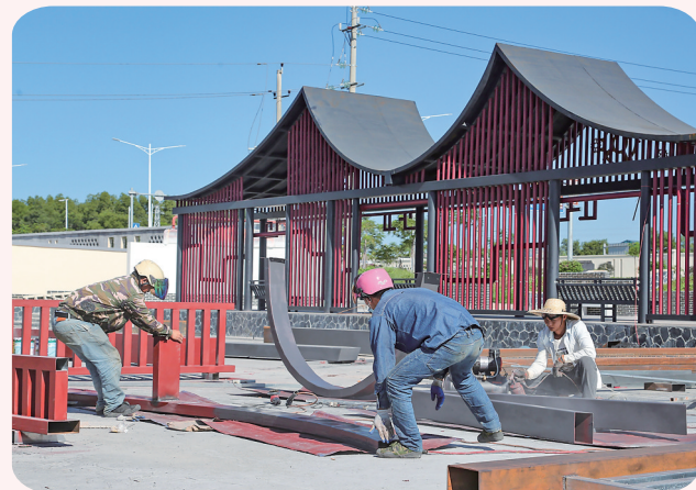
▲施工人员正在紧张施工。茂名日报社全媒体记者岑稳 摄
