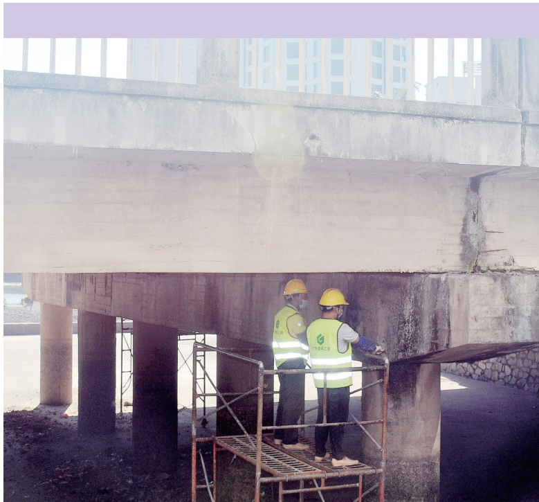
昨日,市区江东北路桥梁维修加固工程正式动工,施工人员正在对桥梁下部结构进行全面的检测。据施工方介绍,该工程预计工期为20天。
