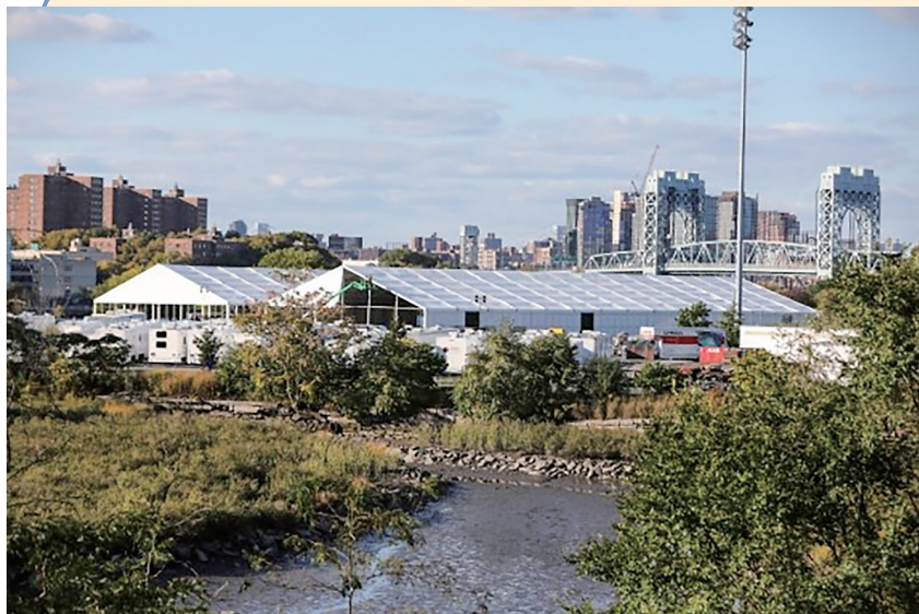
这是10月9日在美国纽约市兰德尔岛拍摄的建设中的移民救援中心。 新华社记者王迎 摄
