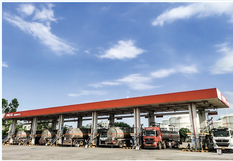
中国石化公馆油库设置24小时不间断应急提油车辆绿色通道。
