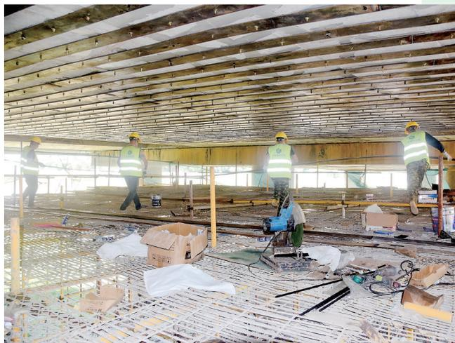
前日，记者在市区竹园桥加固工程施工现场看到，施工人员正在进行桥梁底部钢板铺装粘贴施工。据施工方介绍，该工程预计12月30日完成。
