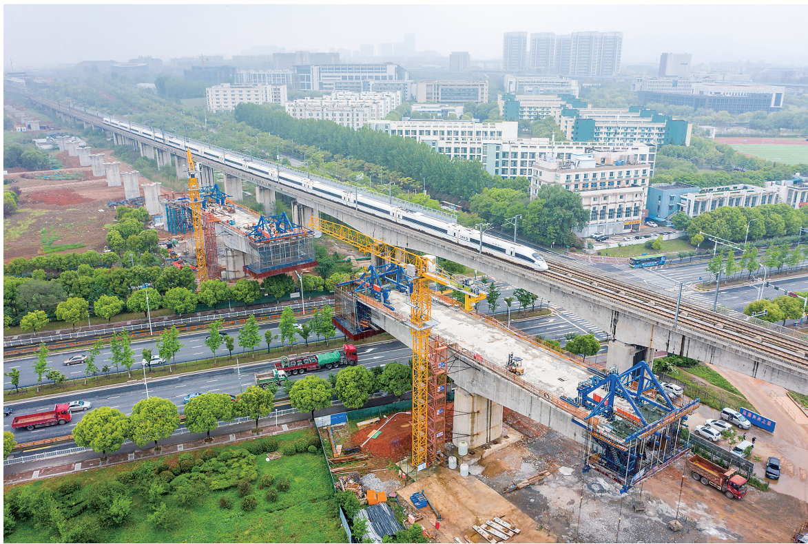
中铁四局四公司的工程人员在江苏南沿江城际铁路站前I标工程跨天元东路连续梁施工点施工作业(2021年4月27日摄，无人机照片)。新华社记者 李博 摄
