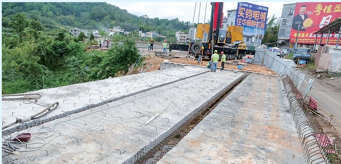
里垌桥重建工程抓紧最后施工。 茂名晚报记者吴祖光 摄
