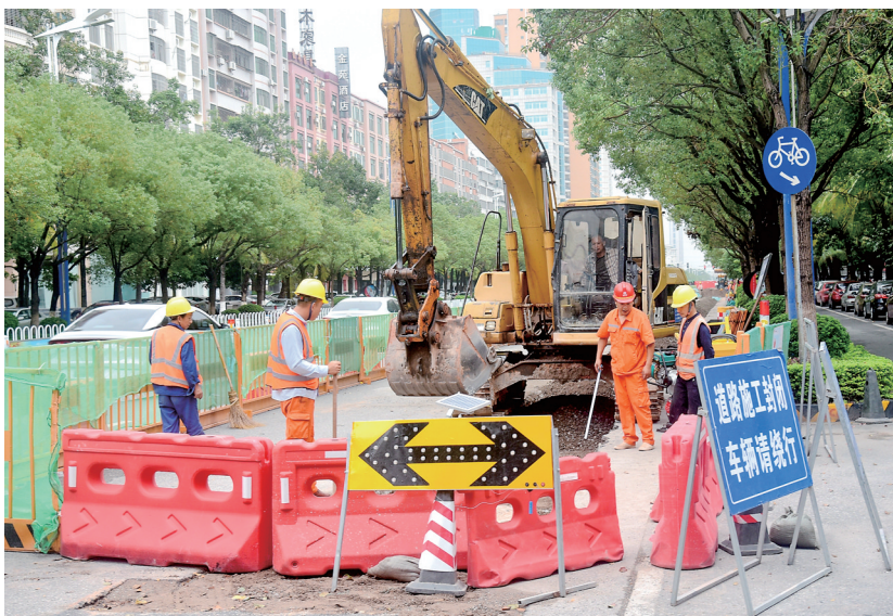
昨日,记者在市区油城七路污水管网建设工程施工现场看到,施工人员正在加紧进行回填施工。据施工方介绍,该工程预计12月15日前完工。 茂名日报社全媒体记者 陈国汉 摄
