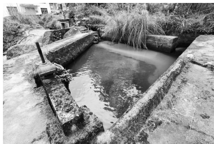
大雾岭总干渠的接水口——河尾河拦水闸。
