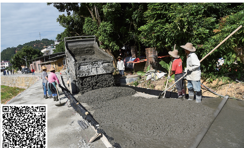
扫一扫，看视频 平山村乡村公路建设施工。茂名日报社全媒体记者黄信涛摄
