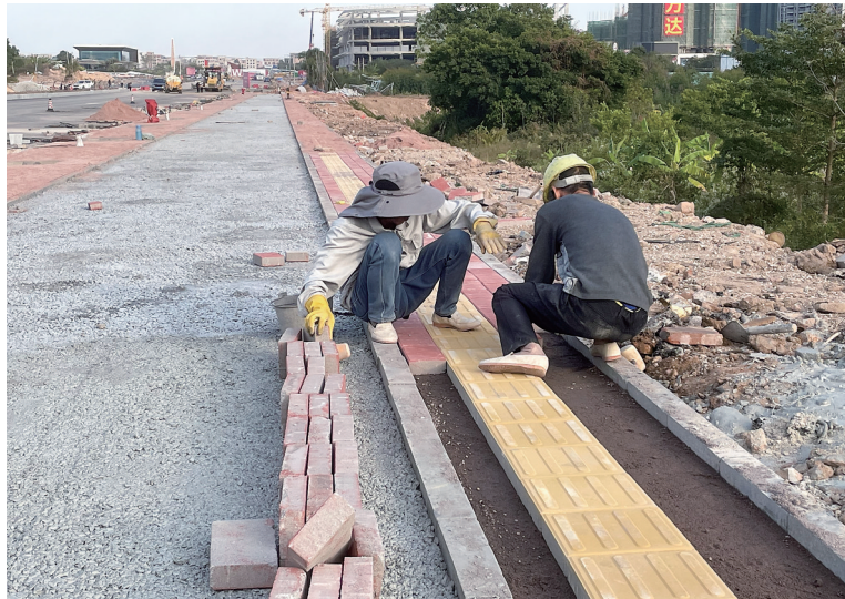
昨日,记者在市区双山八路施工现场看到,主路面已完成了两层沥青路面铺设,施工人员正加紧铺设人行道彩砖,争取工程早日完工。
