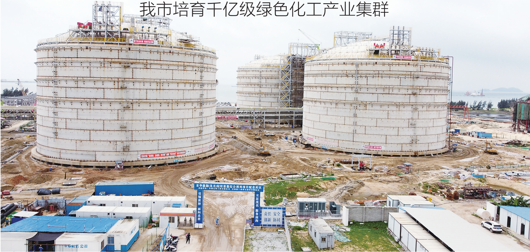
库区一期项目(摄于2022年6月)
