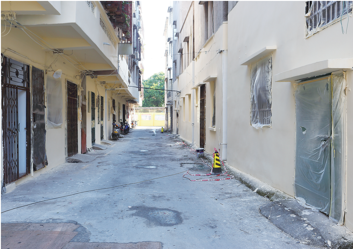
红旗中路245号大院外墙翻新工作基本完工。
