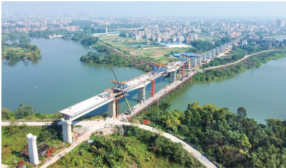
广湛高铁下北斗村段跨袂花江大桥建设。
