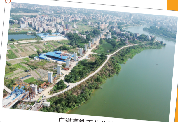
广湛高铁下北斗村段建设好的桥墩。
