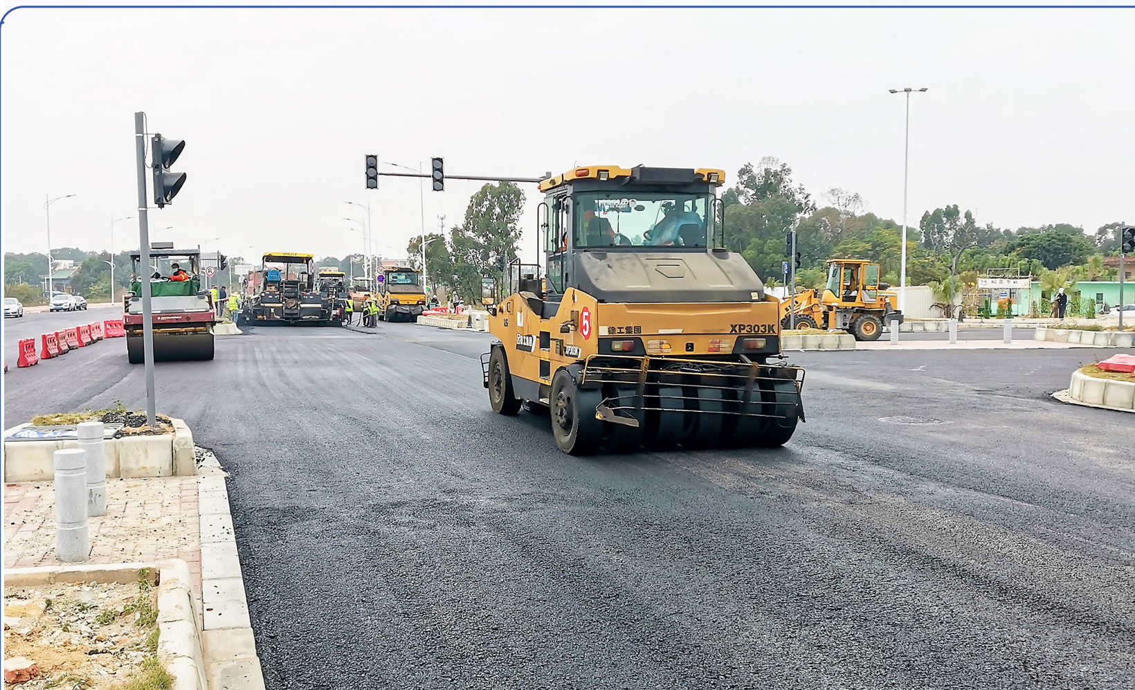
昨天,在水东湾新城海城西路,施工人员正忙于为铺设沥青混凝土路面,进一步完善该片区路网建设。
