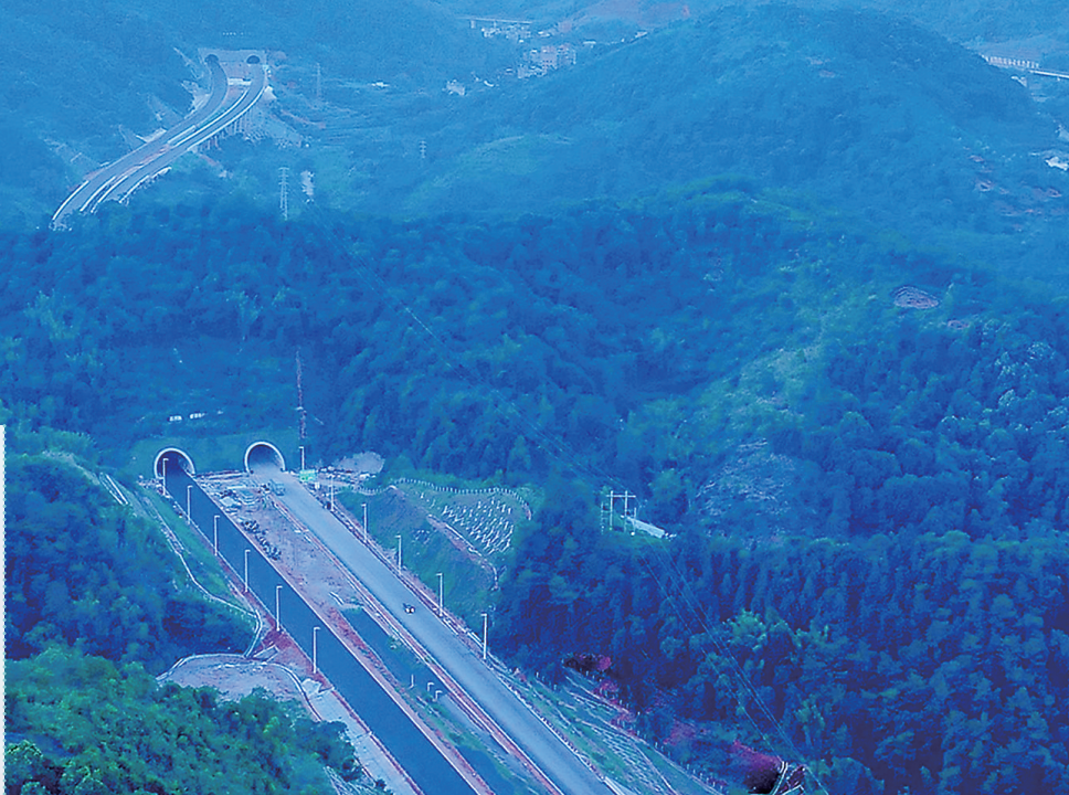
晨曦中的包茂高速(粤境段)平寨1#隧道(靠前)和平寨2#隧道(靠后)。
