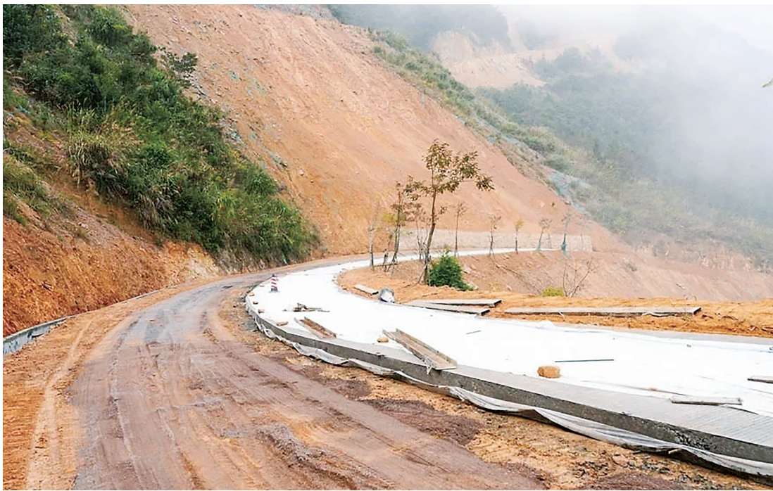
榕大公路冲刺最后300米单边路面硬底化。 茂名晚报通讯员 陆波 摄
