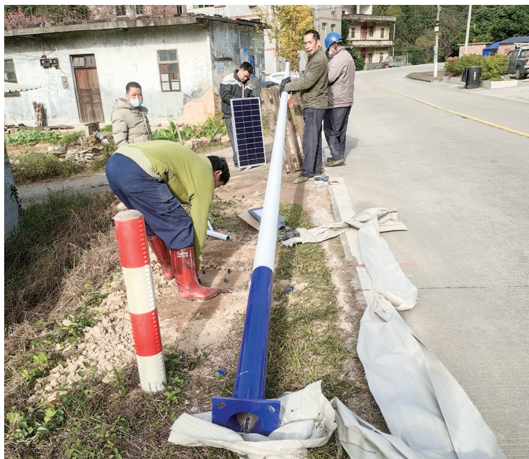
88盏太阳能路灯在厚垌村安装完毕。
