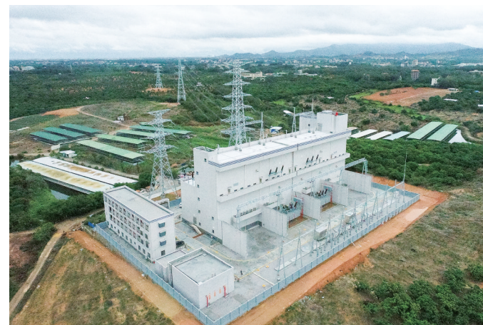
茂名220千伏楼阁堂变电站鸟瞰图。 通讯员 叶泽 摄
