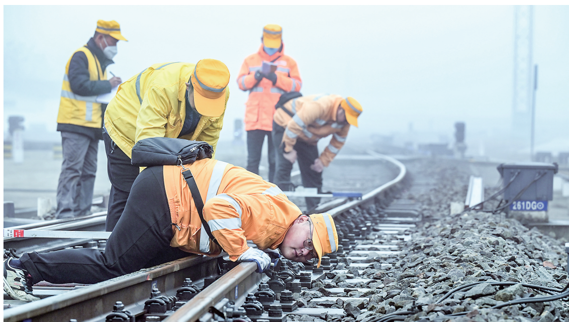
1月13日,中国铁路上海局集团有限公司合肥工务段工作人员在合肥东站进行设备巡查作业。
