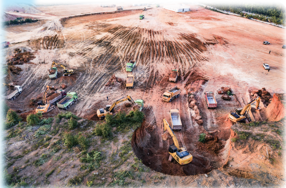
茂南区天然气热电联产保障电源项目施工现场。 茂名日报社全媒体记者 丘立贺 摄
