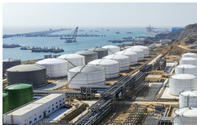
博贺新港区东区码头建设热火朝天。茂名日报社全媒体记者丘立贺 摄
