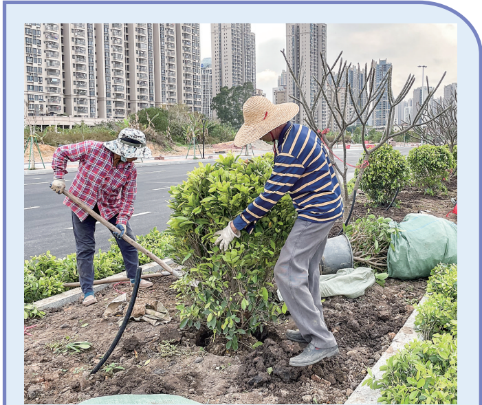
2月13日,记者在市区双山八路施工现场看到,沥青路面铺设已完工,施工人员正加紧进行道路绿化工作,争取工程早日完工。 茂名日报社全媒体记者李颜东 摄
