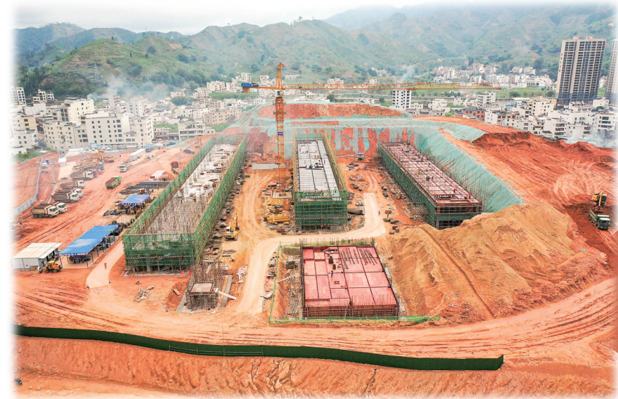
钱排教育园区项目建设现场。
