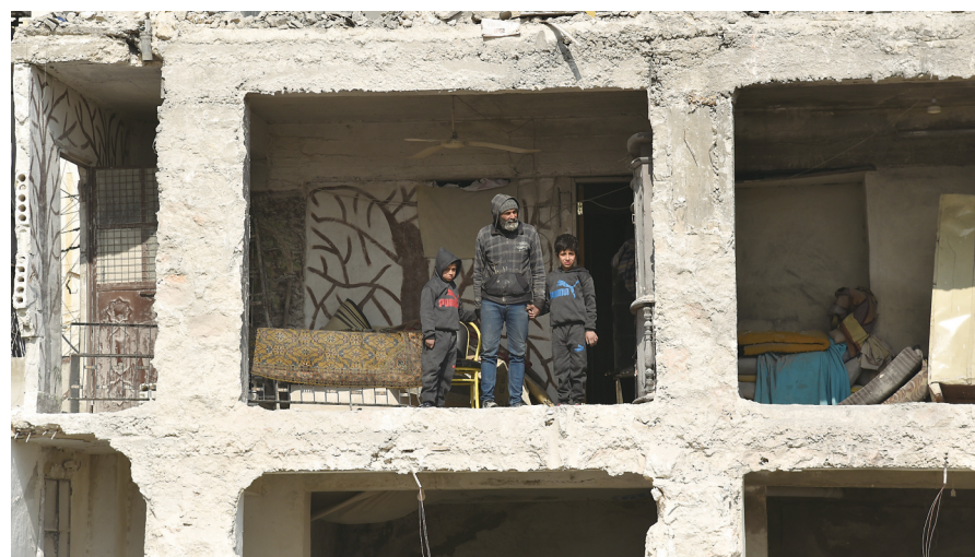
2月13日,在叙利亚地震灾区阿勒颇,人们站在受损的建筑中向外张望。新华社发(蒙塞夫 摄)
