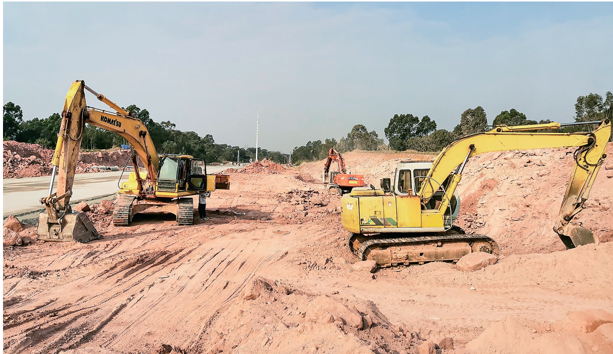
昨天,在甲子大道乘鳌岭路段的工地,挖掘机正忙清理土石方平整路基,抓紧推进建设项目施工进度。 茂名日报社全媒体记者 岑稳 摄
