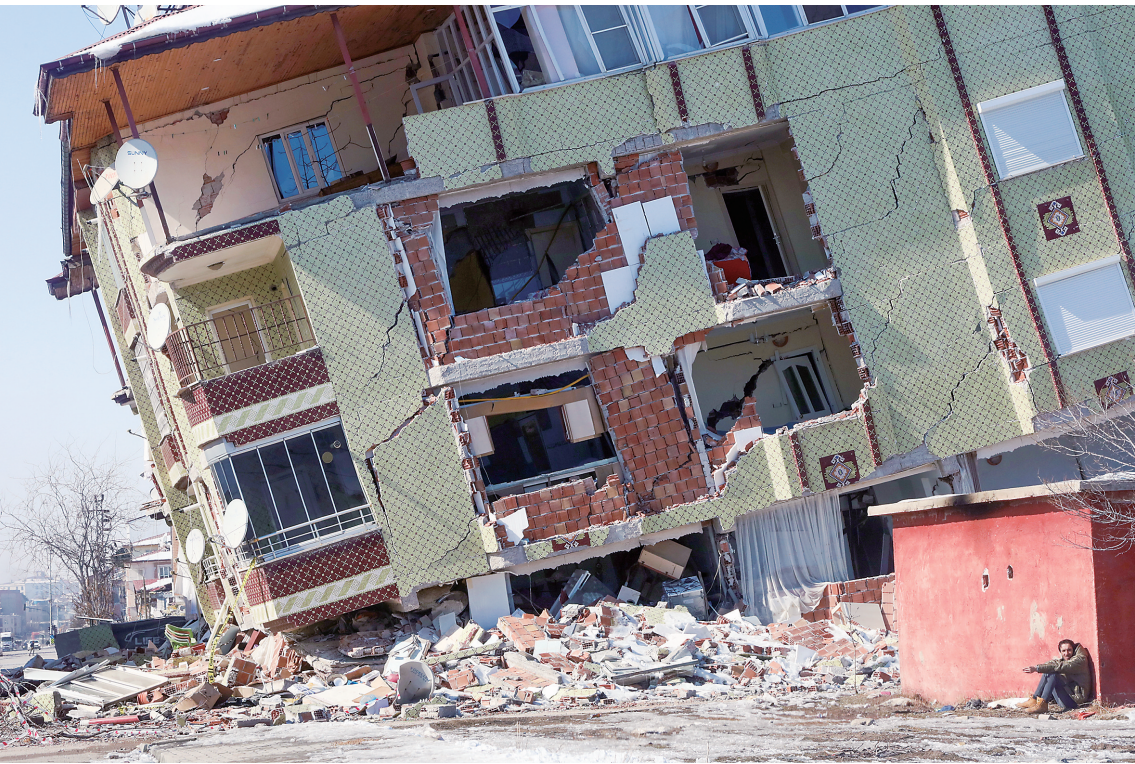
这是2月24日在土耳其卡赫拉曼马拉什拍摄的建筑废墟。 新华社发(穆斯塔法·卡亚摄)
