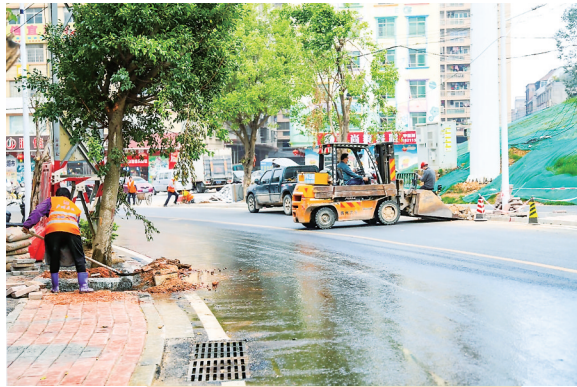
信宜环城东路改建工程收尾。 茂名晚报通讯员 王庆珍 摄
