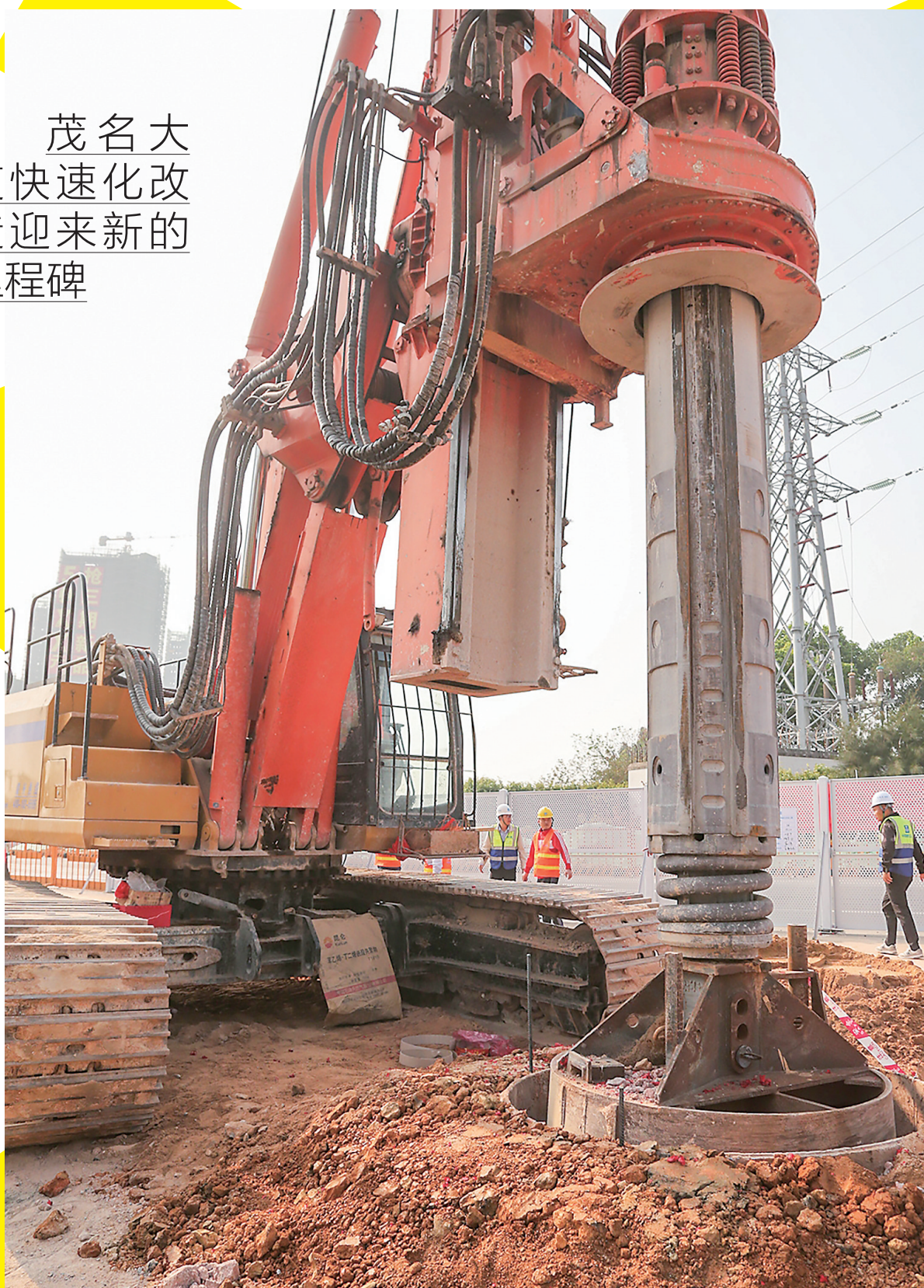
海洋大道立交项目首桩开钻现场。茂名日报社全媒体记者 岑稳 摄
