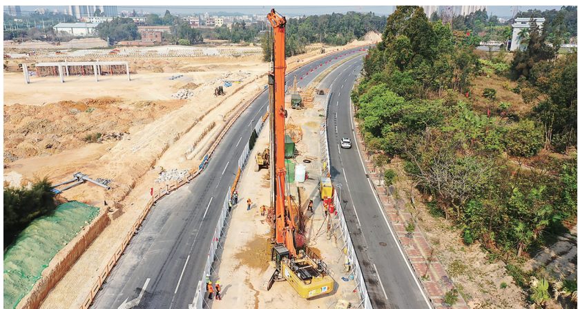
电白海洋大道立交首桩开钻,大型旋转钻在现场施工。茂名日报社全媒体记者 岑稳 通讯员 杨其松 摄
