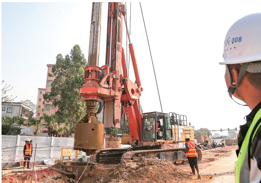
大型施工机械在现场施工。茂名日报社全媒体记者 岑稳 摄
