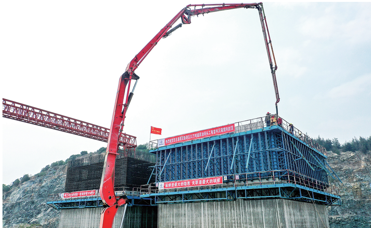
茂名港博贺新港区30万吨级原油码头工程首件沉箱顺利封顶。
