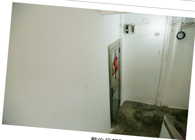
整治后朝阳社区整洁干净
