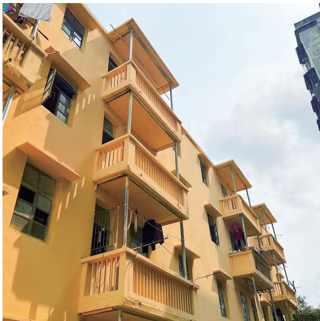
红旗街道老旧小区改造项目逐步推进,居民楼外立面粉刷一新。 茂名晚报记者 李仁娟 摄
