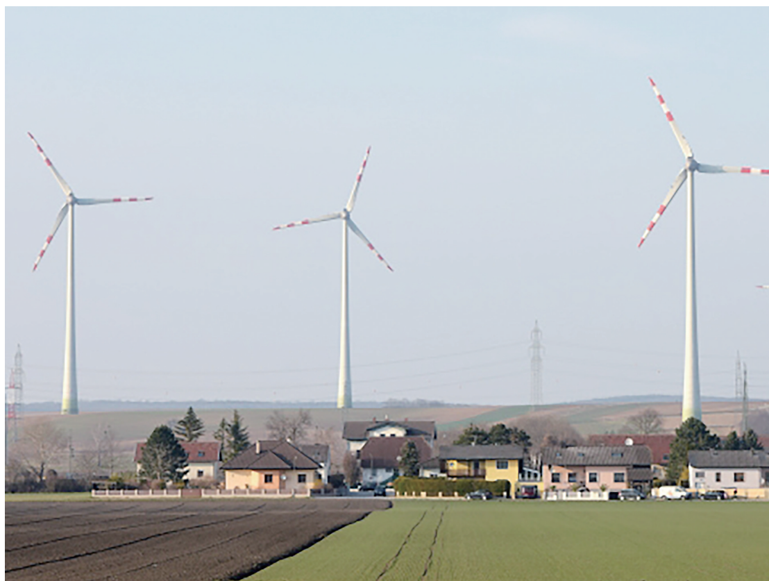
奥地利下奥地利州的风力发电机。新华社记者郭晨摄
