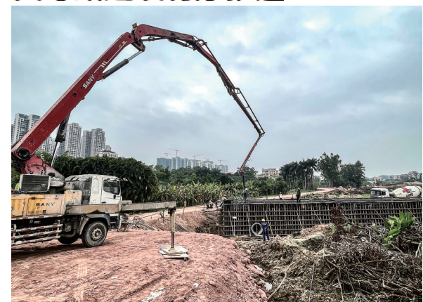
昨日,记者在市区文才路施工现场看到,施工人员正加紧进行路基平整和箱涵浇筑施工,现场一派繁忙景象。据悉,文才路全长757.731米,道路呈东西走向,起点与茂名大道相交,终点接东粤路。 茂名日报社全媒体记者李颜东 摄
