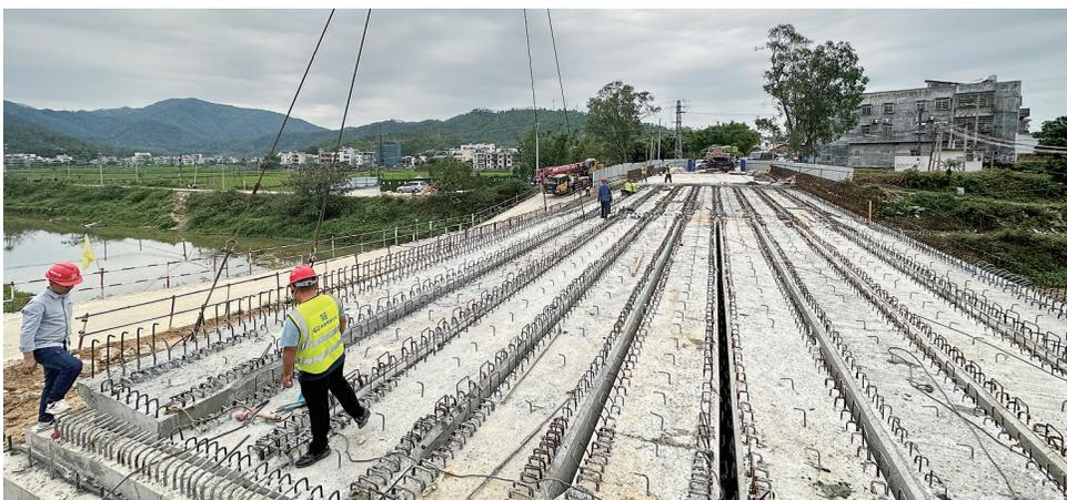
茂名晚报讯 记者梁奈 通讯员陈治 11日,随着最后一块16米长的砼空心板桥被缓缓吊起,在紧张有序的指挥哨声中平稳移动,最终精准地落在桥梁支座上。这标志着由中铁七局集团武汉工程有限公司承建的信宜市省道S283平山桥危桥改造架梁工程基本完成。
