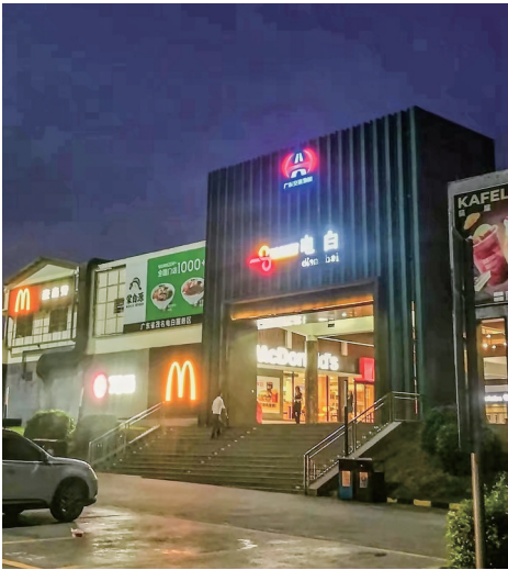
▲沈海高速电白服务区。
