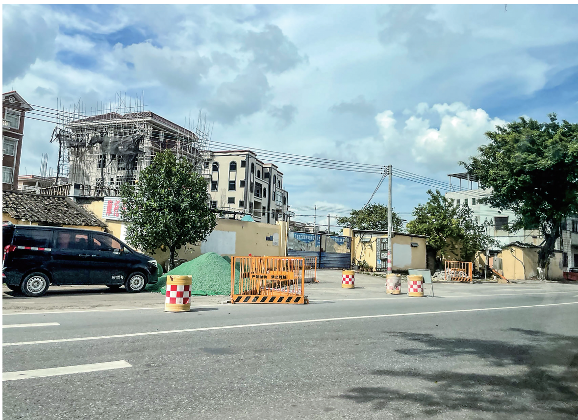
茂名西站以东路段某处施工点已拆除围挡。 记者 李君平 摄
