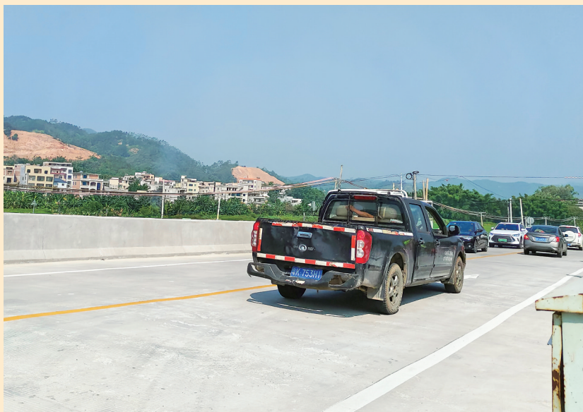
平山桥危桥改造完成。茂名晚报记者梁奈 摄
