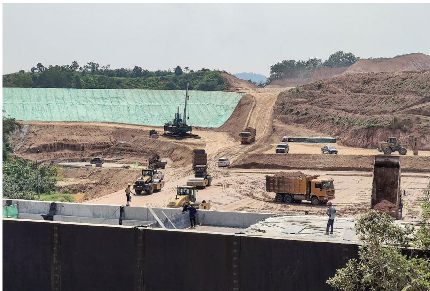
东互通施工现场。 茂名晚报记者梁奈 摄
