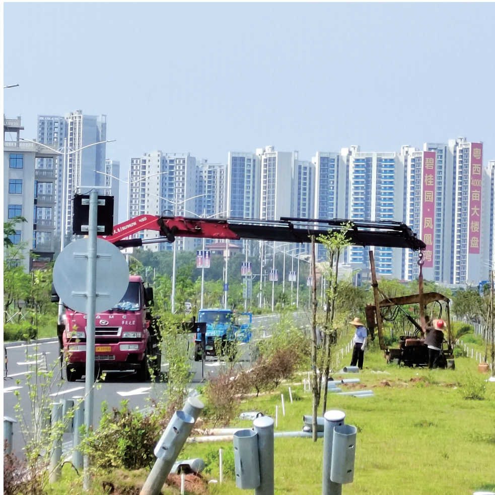
工作人员在拆装公路防护铁皮。茂名晚报记者李光耀 摄
