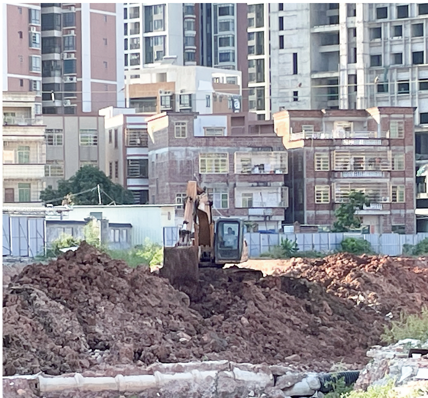
昨日,在市区的人民南五、六路施工现场,施工人员顶着烈日平整路基,争取工程早日完工。 茂名日报社全媒体记者 李颜东 摄
