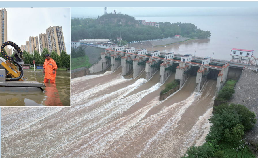
7月31日,位于石家庄市鹿泉区的黄壁庄水库加大泄洪流量(无人机照片)。新华社发(白云飞摄)
