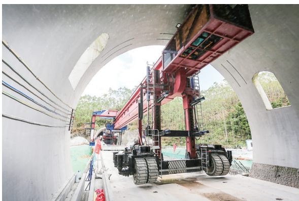
架桥机将32米长、重达830吨的箱梁吊装到位。
