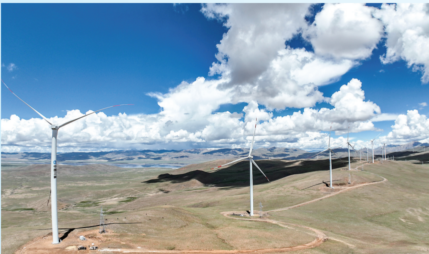
西藏措美哲古风电场。(三峡集团供图)
