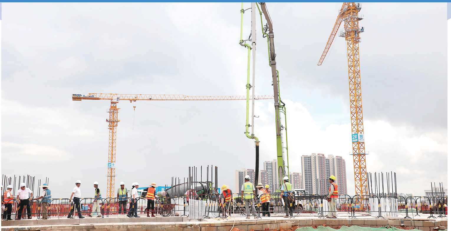
茂名奥体中心体育场项目建设现场。通讯员 易剑梅 摄
