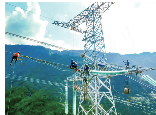
这是电力工人在工程现场开展高空施工作业。(国网重庆市电力公司供图)
