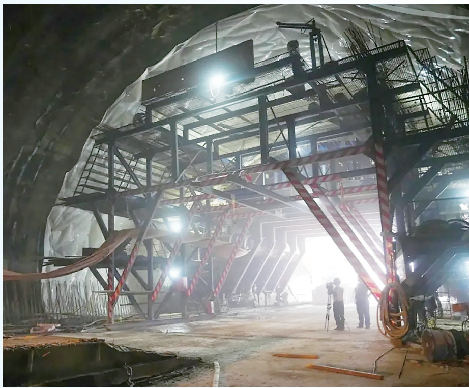
金钗岭隧道抓紧施工。通讯员陆波 摄
