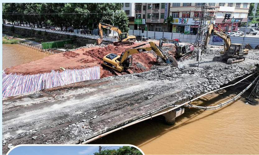
▲施工现场。 茂名晚报通讯员陆波 摄
